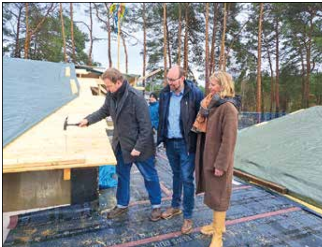
Symbolisch letzter Nagelschlag beim Richtfest durch Hrn. Pietzsch Foto: K. Brackmann
